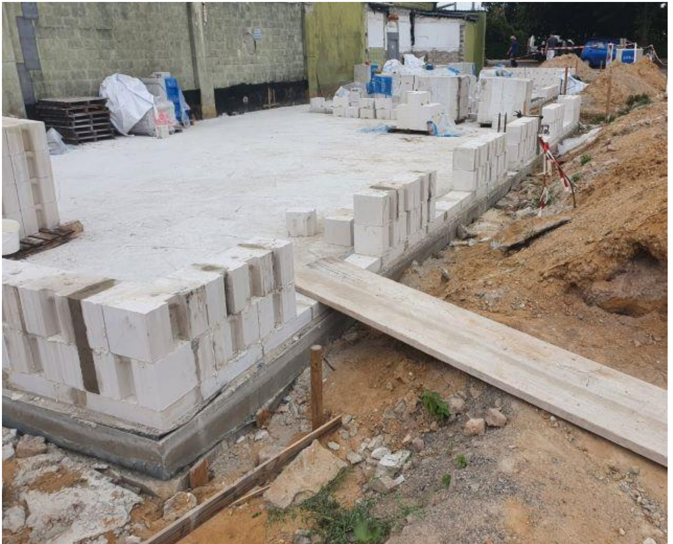
Man erkennt schon gut die Öffnungen für die bodentiefen Fenster
